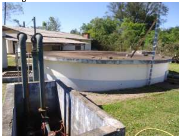
Figura 57 - Reservatório Semi-enterrado
