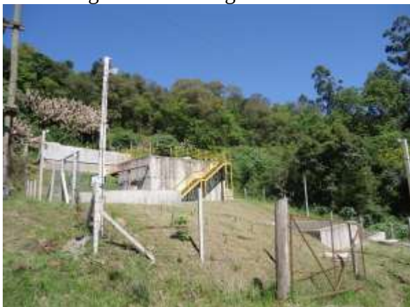
Figura 66 - Vista geral da ETE
