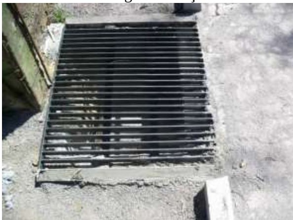
Figura 109 - Detalhe de uma boca de lobo com grade de aço
