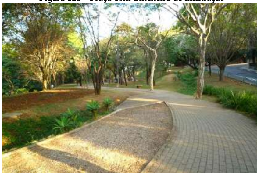
Figura 129 - Praça com trincheira de infiltração
