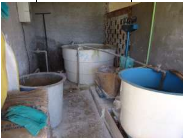
Figura 54 - Vista geral de um dos departamentos da casa de química
