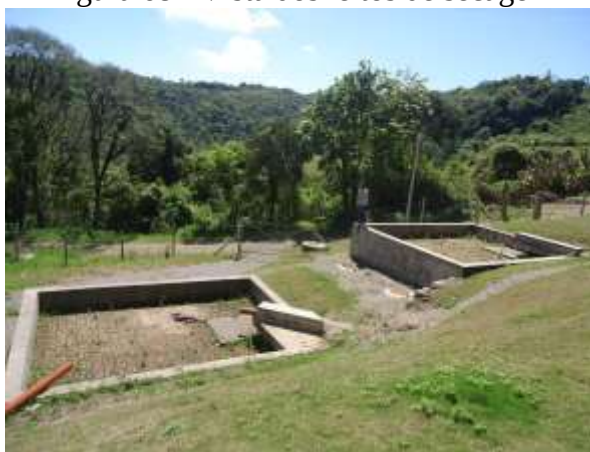
Figura 68 - Vista dos leitos de secagem
