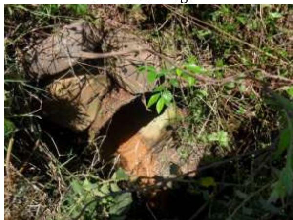
Figura 104 - Tubulação de concreto (0,40 m) da microdrenagem
