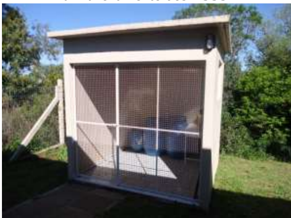
Figura 94 - Local temporário de armazenamento dos RSSS
