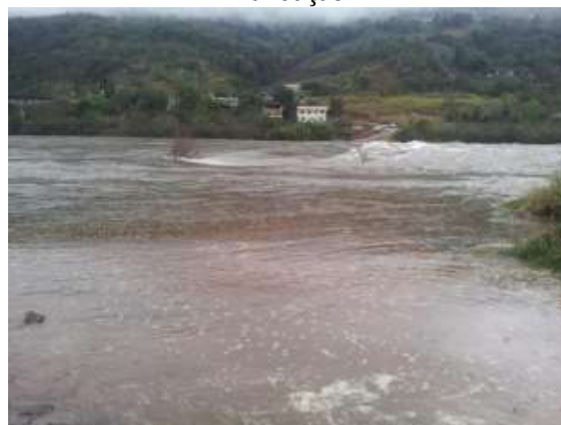
Figura 117- Ponte que liga os municípios de Cotiporã e Bento Gonçalves, submersa por uma inundação
