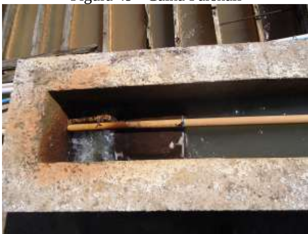
Figura 49 - Calha Parshall
