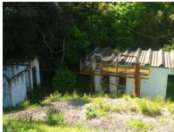
Figura 48 - Vista geral da EEAB, ao fundo a AAB
