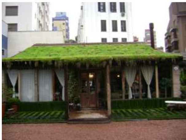
Figura 127 - Casa com telhado verde
