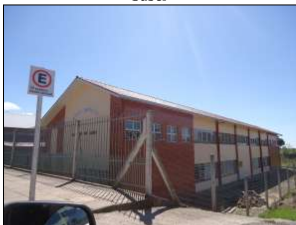
Figura 37 - Escola Municipal Caminhos dos Saber
