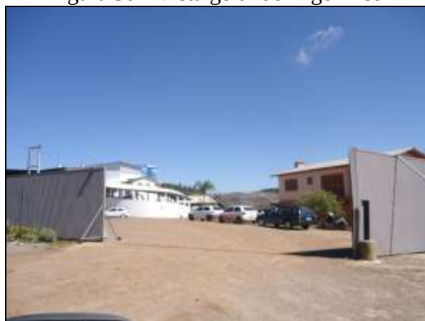
Figura 30 - Vista geral do frigorífico
