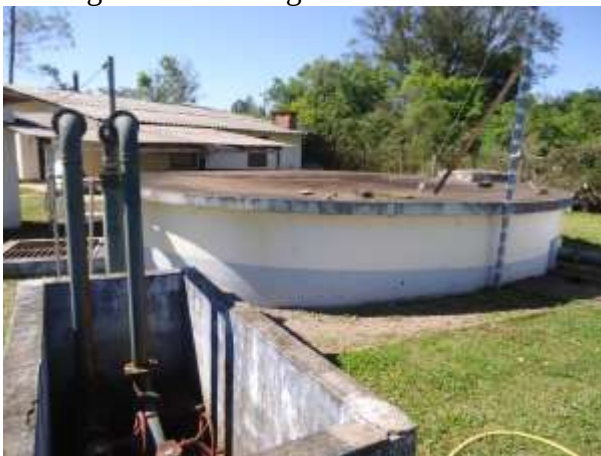
Figura 53 - Vista geral do reservatório
