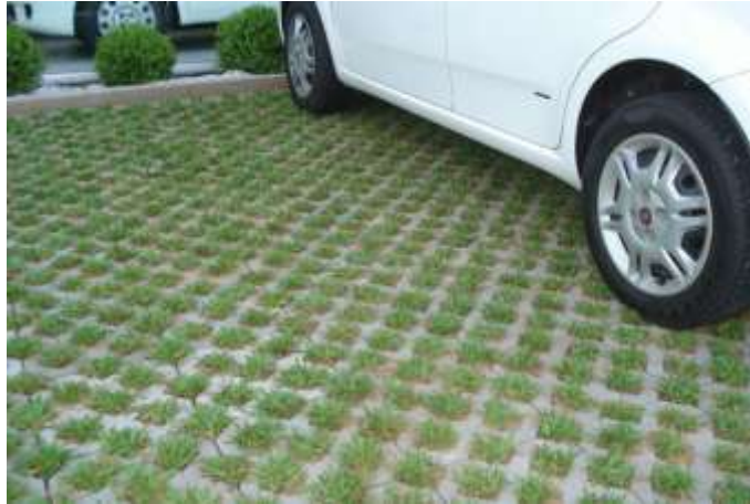
Figura 126 - Exemplo de pavimento poroso (bloquetes vazados)
