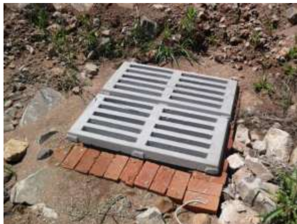
Figura 110 - Boca de lobo com grade de concreto
