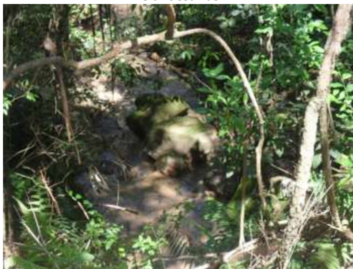
Figura 115- Conexão da tubulação de macrodrenagem em um pequeno córrego, com evidências de ligações clandestinas
