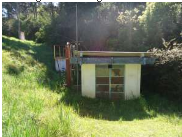
Figura 47 - Vista geral da EEAB
