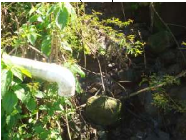
Figura 69 - Esgoto sem tratamento e destinação adequados
