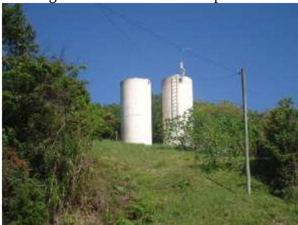
Figura 56 - Reservatórios Apoiados
