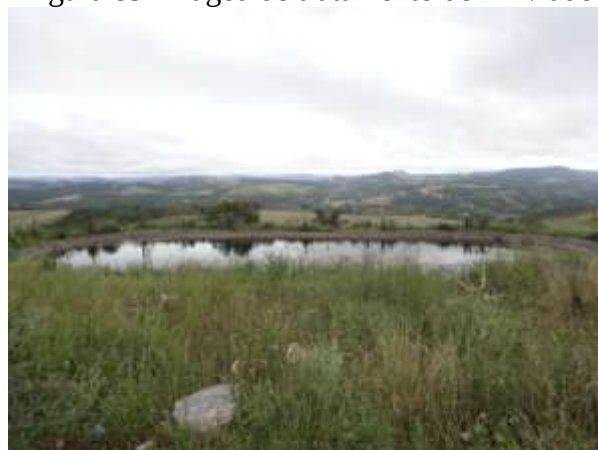
Figura 89 - Lagoa de tratamento de lixiviado
